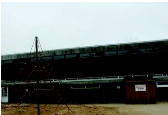
Abbildung 12: (links) Außenwand, massiv, mit Oberlichtern, (rechts) Brüstungselemente und Kunststofffenster mit Wärmeschutzverglasung
